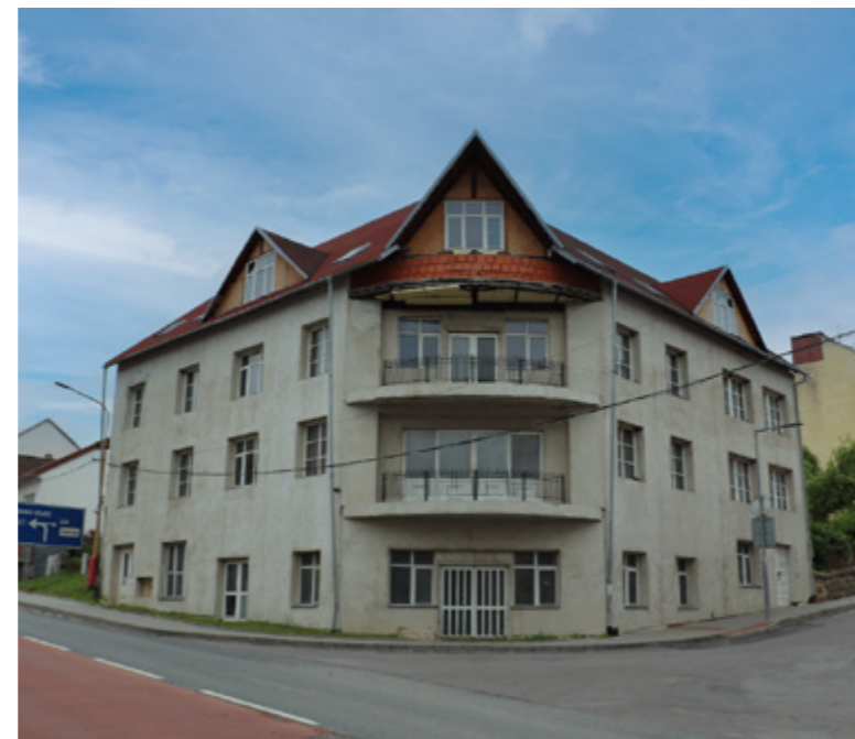
Dům na rohu · proměna brownfieldu v podnikatelské centrum · Valašské Klobouky ↑ Před rekonstrukcí · po rekonstrukci →
